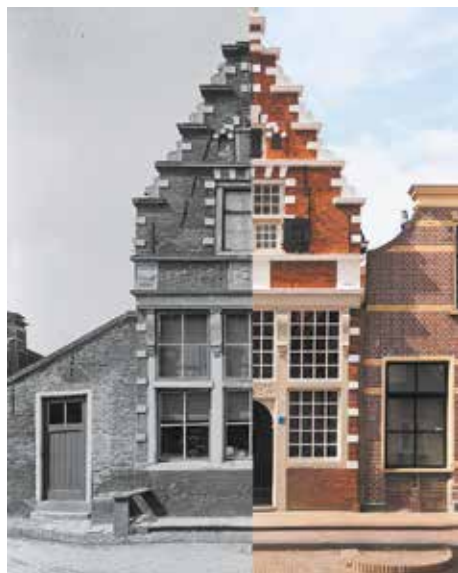
Breedstraat 102 in Enkhuizen, voor en na de restauratie.
